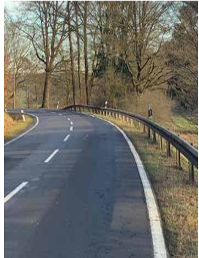
Netzrisse, Flickstellen und Durchbrüche
