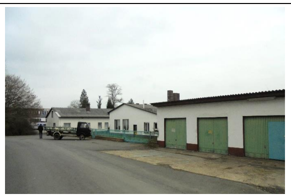
Blickrichtung Nordost (Ehemaliger Großhandelsbetriebes ausgehend vom Ernteweg)
