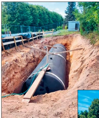
In Josbach wurde die Baumaßnahme für die Löschwasserzisterne beendet. Die Zisterne mit einem Volumen von 100 m<sup>3</sup> dient der Feuerwehr als Ergänzung zur Löschwasserversorgung, da gerade in den Sommermonaten kein Verlass mehr auf Wasser aus dem am Ort vorbeifließenden Josbach ist.
